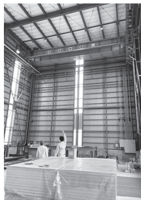
新設された第5工場の内部
