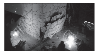
図2 劣化した鉄筋コンクリート柱の 載荷試験状況 (かぶりコンクリートが一斉に剥落)
