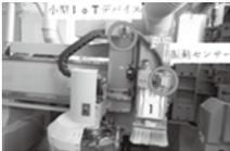
センサー設置状況 | 冷蔵庫・冷凍庫にIoTセンサーを設置して、庫内温湿度のリアルタイム取得を実施。<br>
