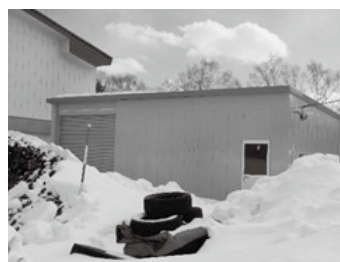
廃菌床乾燥設備
